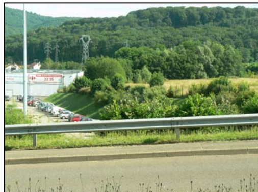
Talus réalisé pour les parkings de l'enseigne Carrefour.
